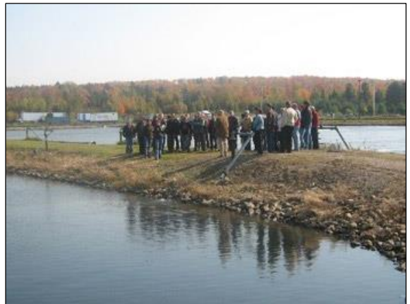
Journée portes ouvertes à la station d'épuration de Sainte-Marie (Beauce) - Photo : MDDELCC.
