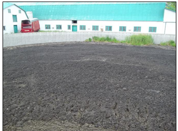
Structure en béton utilisée pour le stockage temporaire de biosolides municipaux pâteux destinés à une utilisation en tant qu'engrais organique liquide. Crédit photo : Viridis Environnement.
