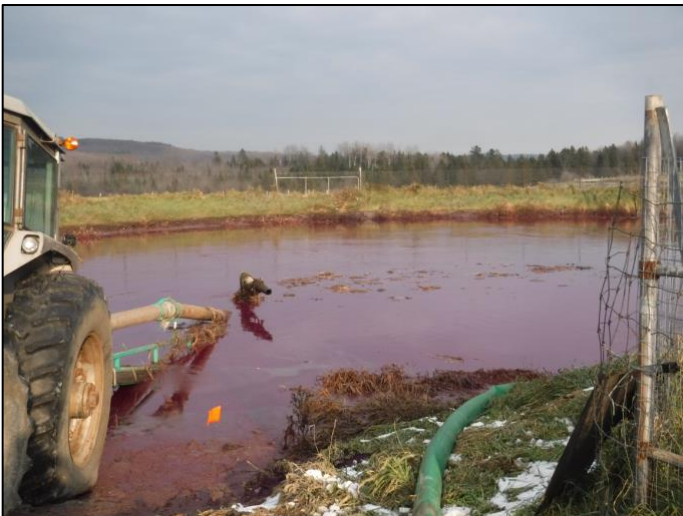
Stockage de MRF agroalimentaires liquides dans une structure étanche en argile. Crédit photo : Bélanger Agro-consultant.
