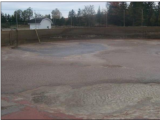
Stockage de boues d'abattoirs chaulées dans une fosse en béton (source : MELCC).
