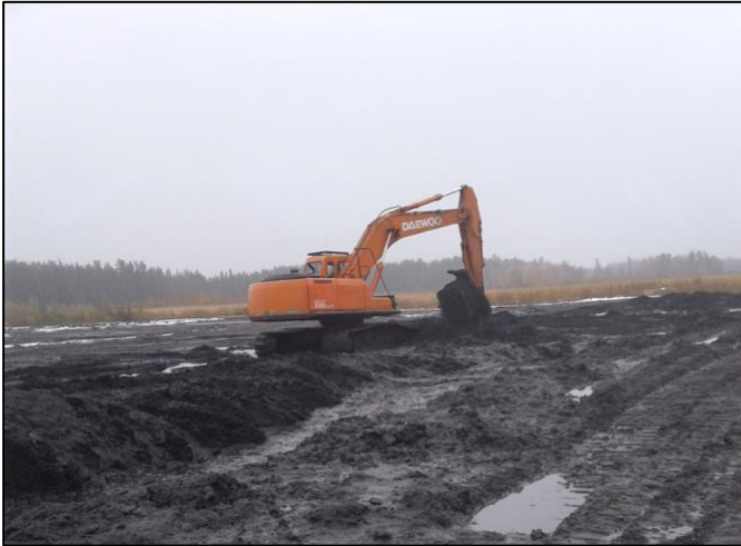
Incorporation à la pelle mécanique de doses élevées de cendres aux résidus miniers (crédit photo : Marc Hébert).
